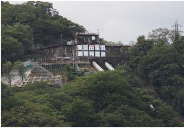
写真1 / 落差102mの導水管の上に設置された駒橋発電所看板
